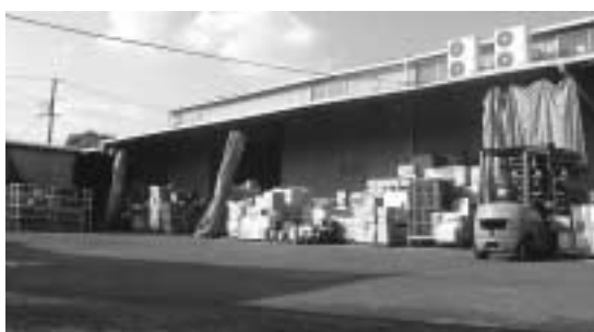
資材部倉庫外観風景
