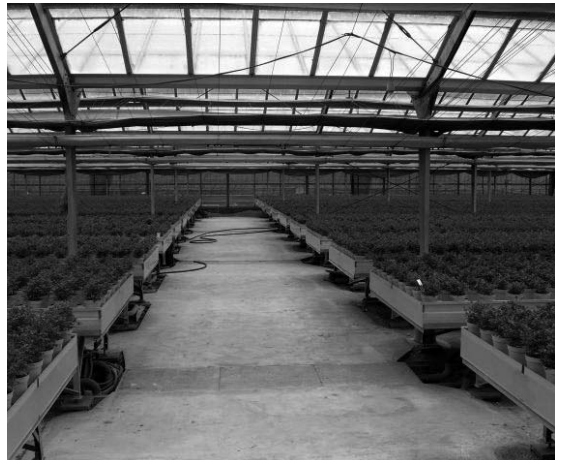
写真③ 施設内のエプ&フロア給水装置 ミニバラ生育中
