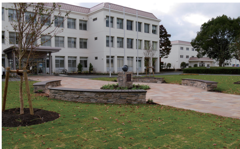
つい先日竣工した県立農業大学校創立 100 周年を記念した校舎前広場の庭 自然石で作ったサークル型のベンチが学生たちの語らいの場所を提供する
